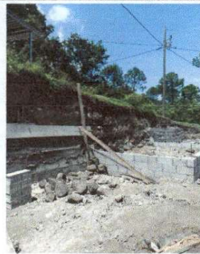
Foto 2: Construcción de la circulación de pared de block y malla.
