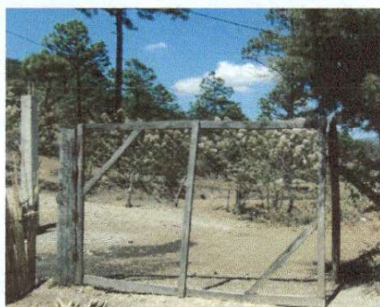
Foto 5: Portó en construcción.
