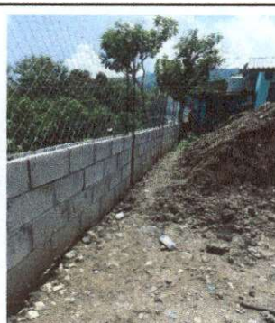
Foto 3: Construcción de la circulación de pared de block y malla.
