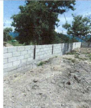
Foto 2: Construcción de la circulación de pared de block y malla.
