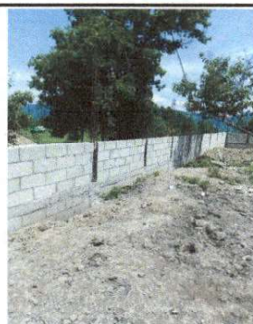
Foto 4: Construcción de la circulación de pared de block y malla.
