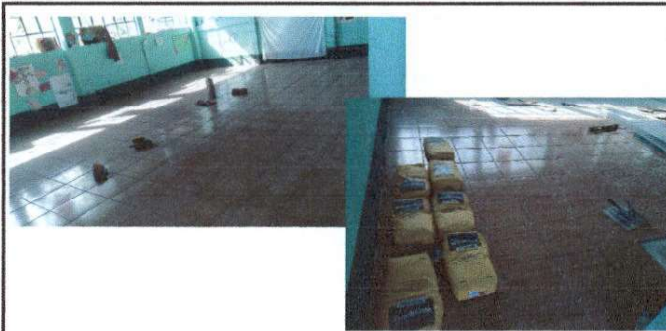
Foto 6: Proceso de cambio de torta de pizo por pizo cerámico.
