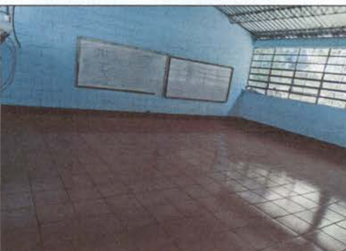
Foto 6: Finalización de piso cerámico en aulas.
