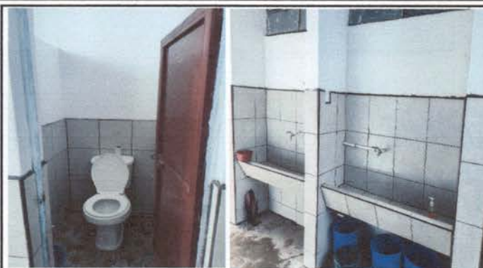
Foto 2: Colocación de exterior de azulejo en lavamanos.
