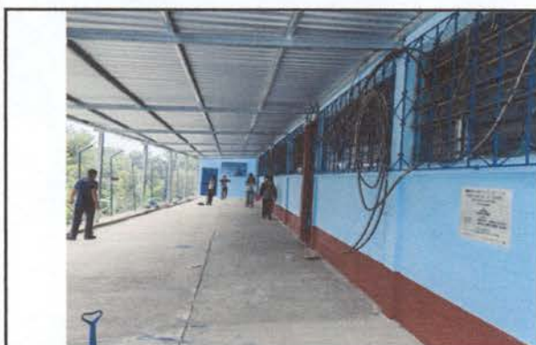
Foto 3: Finalización del techado.
