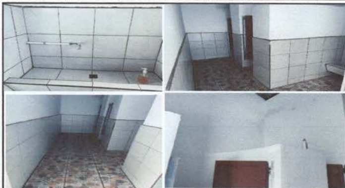
Foto1: Terminación de azulejo en lavamanos y todo el interior de baños.
