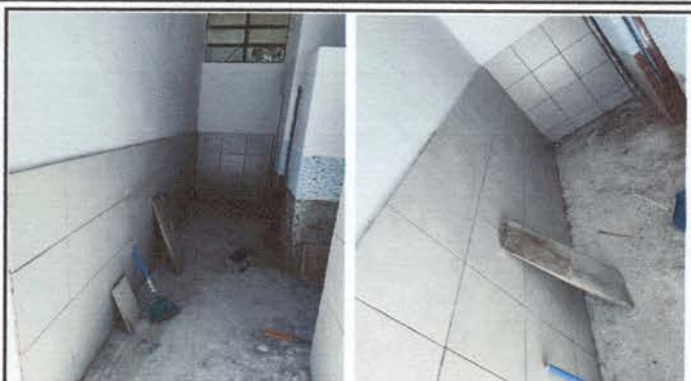
Foto 2: Se observa la colocación de piso cerámico
