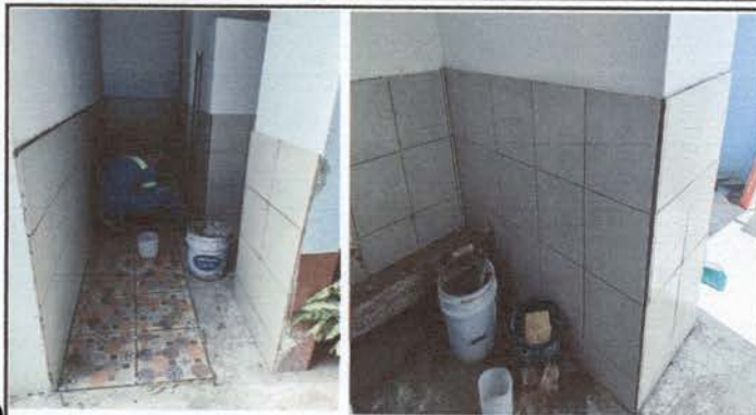
Foto1: Se observa la colocación de azulejo
