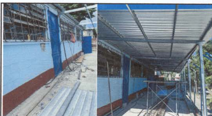
Foto 4: Colocación de estructura metálica y lamina.
