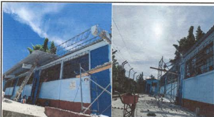
Foto 3: Desmontación de columnas y láminas
