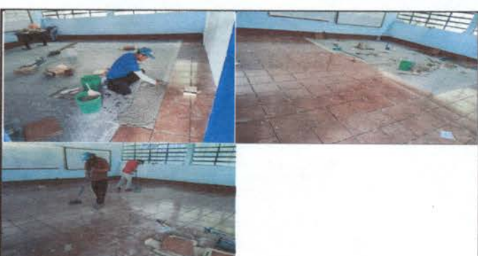
Foto 6: Colocación de piso cerámico en aulas.
