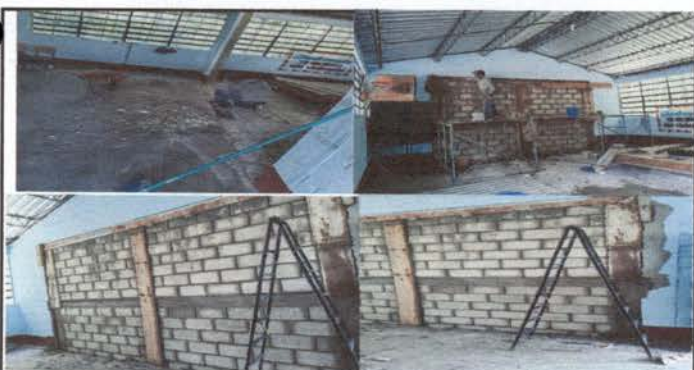
Foto 5: Levantado de pared intermedia entre dos salones.
