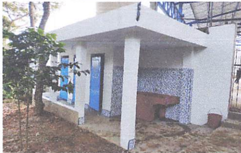
Foto 1. Módulos de Sanitarios
