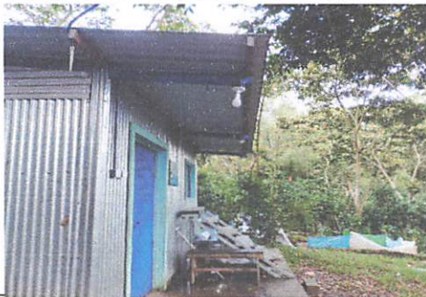
Foto 3: Instalación de Energía eléctrica en Cocina
