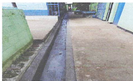
Foto 4: Fundición de cuneta para pilas
