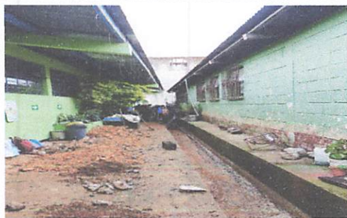
Foto 3. Zanjeado para construcción de cuneta
