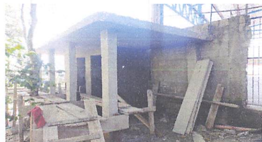
Foto 1. Construcción de modulo de Sanitario
