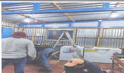
Foto 5: Instalación de luz eléctrica en cocina
