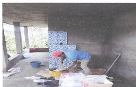
Foto 2: Construcción de Sanitarios
