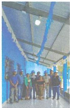
FINALIZACION DE INSTALACION DE ENERGIA ELECTRICA EN AREA DE COCINA, COMEDOR 1,2 Y BODEGA 1
