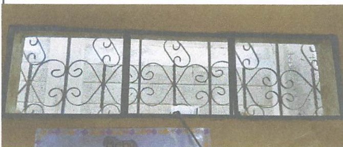
COLOCACION DE VIDREOS EN EL AREA DE COCINA, SALONES DE CLASES
