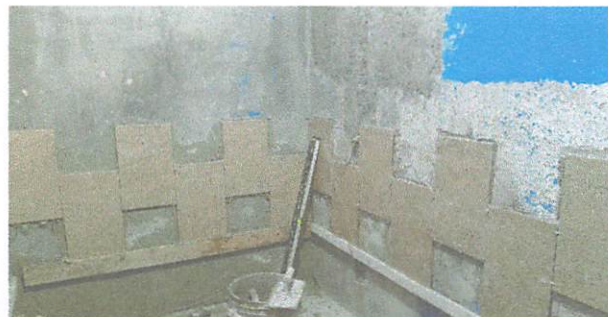
COCLOCACION DE PISO EN EL AREA DE SANITARIOS
