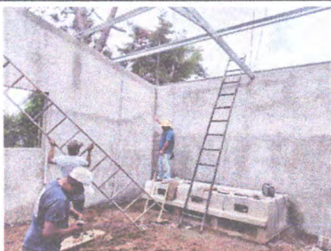
Techado de cocina en proceso
