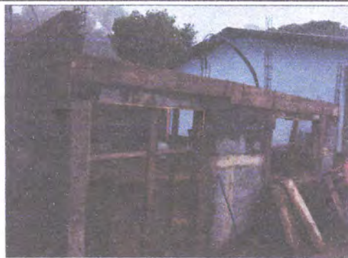
Pared, puerta y ventana en proceso
