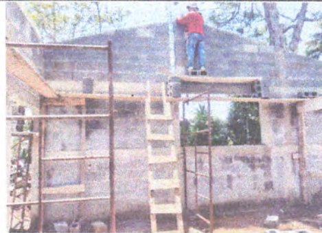
Columna de cocina en proceso
