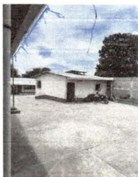
Foto 1: Cocina con necesidad de ampliación
