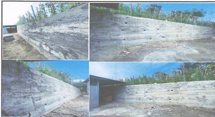
Foto1: Muro de contención de 20 metros de largo y 4 metros de alto
