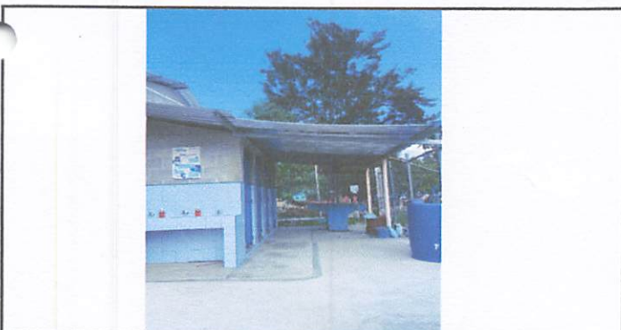
Foto 5: Remodelación de lavamanos y reparación de piso de concreto.
