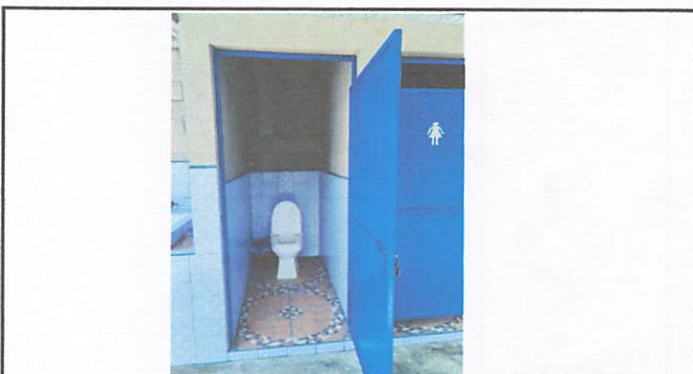
Foto 4: Remodelación de los cuatro baños, colocación de pisos y azulejos.
