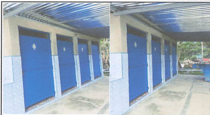
Foto 2: Mantenimiento de las cuatro puertas de los baños, ampliación de piso de torta.
