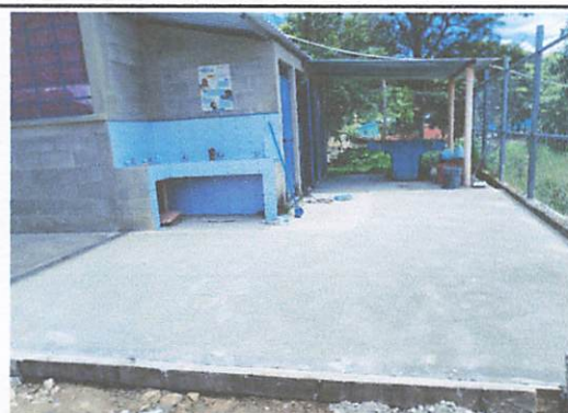
Foto 2: Mantenimiento de las cuatro puertas de los baños, ampliación de piso de torta.
