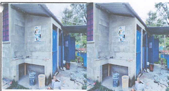
Foto 5: Remodelación de lavamanos y reparación de piso de concreto.
