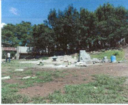
Foto 1: Contrucción de muro perimetral finalizado.
