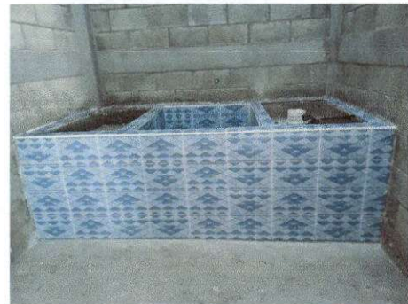
Foto 4: Construcción de pila finalizado.
