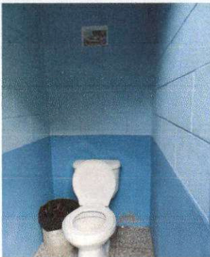
Foto 3: Cambio de accesorios para sanitario finalizado.
