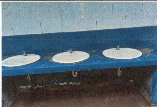
Foto 5: Cambio de accesorios de lavamanos finalizado.
