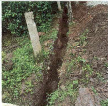
Foto 1: Inicio de zanja para el muro perimetral.
