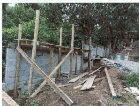
Foto 2: Avance de muro perimetral.
