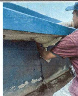
Foto 4: Cambio de tubería para lavamanos.
