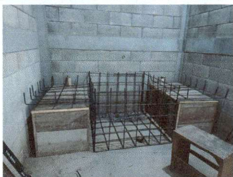
Foto 3: Avance de la pila dentro de la cocina.
