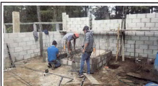
Foto 6: Construcción de pila
