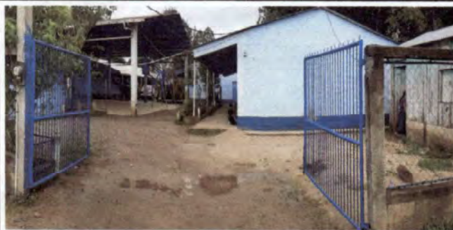
Foto 1: Entrada principal del centro educativo.
