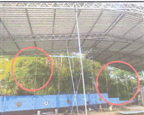
Foto 3: Instalación de refuerzos sobre estructura metálica.
