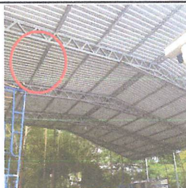
Foto2: aplicación de pintura metálica a costaneras y estructura.
