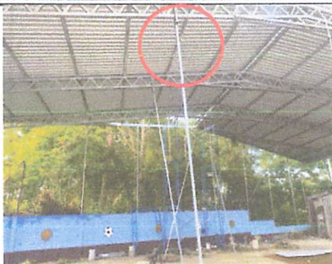
Foto 1: Instalación de láminas sobre estructura metálica.
