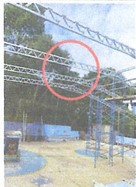
Foto 1: Sustitución de costaneras y vigas de madera por armado de nueva estructura metálica
