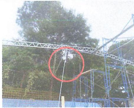
Foto 2: Levantamiento de estructura para techos.
