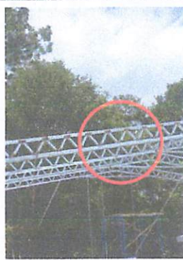
Foto 1: Sustitución de costaneras y vigas de madera por armado de nueva estructura metálica
