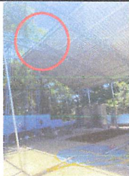
Foto 5: instalación de techo.
