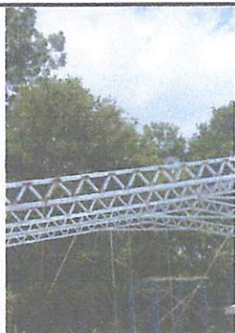
Foto 3: Armado de estructura, para instalación de nuevo techo.
