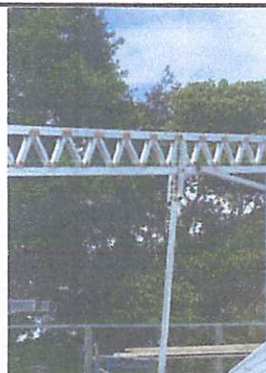
Foto 3: Armado de estructura, para instalación de nuevo techo.
