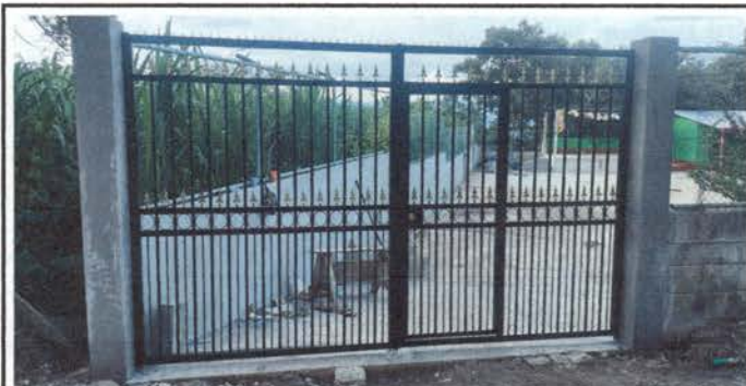
Foto 6: Cambio de portón principal del establecimiento por deterioro, de 4.20 m de ancho por 2.20 m de alto.
