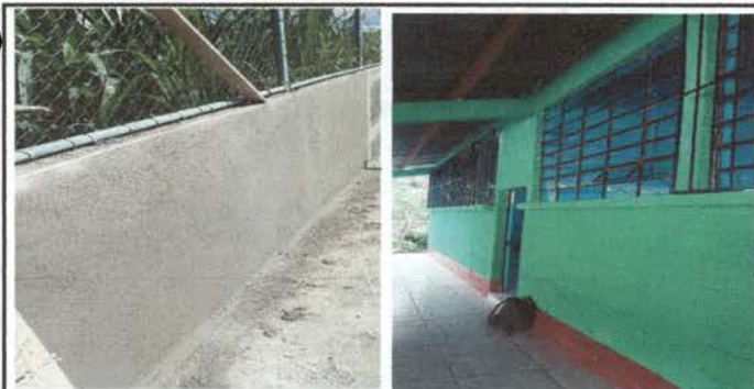
Foto 5: Repello de un muro de circulación de escuela por deterioro de 50 m2. para su protección. Y Pintura para 3 salones de clases, 4 sanitarios y cocina.
