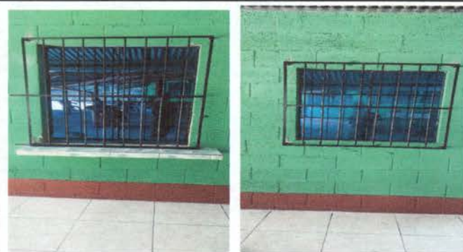
Foto 2: Cambio de 20 pies de vidrio de ventana de cocina. E instalación de 2 m2 de balcón
