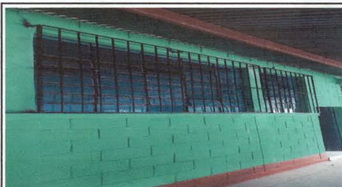
Foto 4: Cambio de 92 piezas de vidrios quebrados de 3 salones de clases, de 1 pie cada uno e instalación de 30 m2 de balcones de 3 salones de clases.
