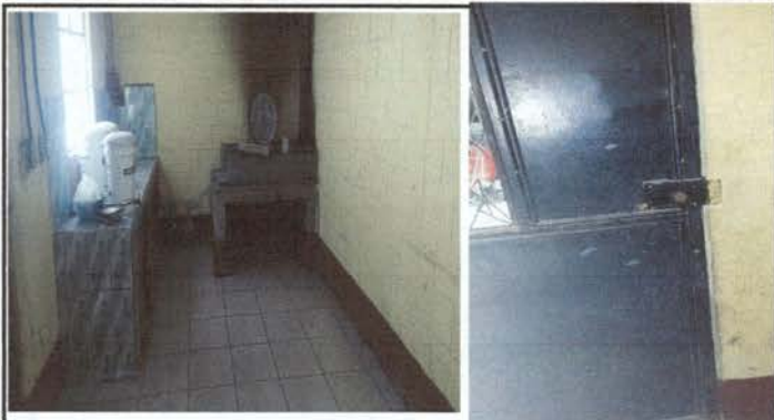
Foto1: Instalación de 36 m2. De piso cerámico en área de cocina y corredor. Cambio de chapa de puerta de cocina por deterioro.
