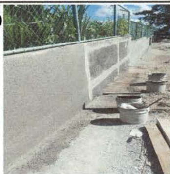
Foto 5: Repello de un muro de circulación de escuela por deterioro de 50 m2. para su protección. Y Pintura para 3 salones de clases, 4 sanitarios y cocina.
