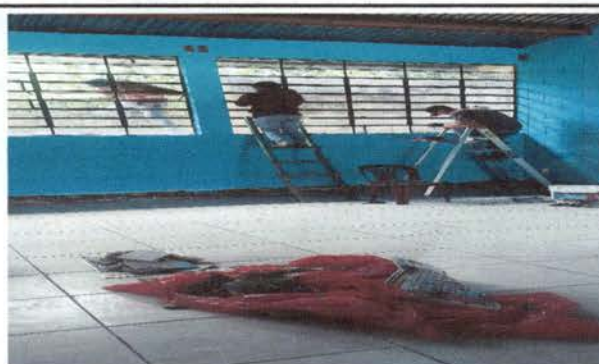
Foto 4: Cambio de 92 piezas de vidrios quebrados de 3 salones de clases, de 1 pie cada uno e instalación de 30 m2 de balcones de 3 salones de clases.
