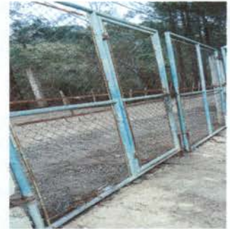
Foto 6: Cambio de portón principal del establecimiento por deterioro, de 4.20 m de ancho por 2.20 m de alto.
