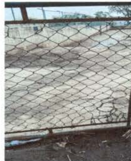
Foto 6: Cambio de portón principal del establecimiento por deterioro, de 4.20 m de ancho por 2.20 m de alto.
