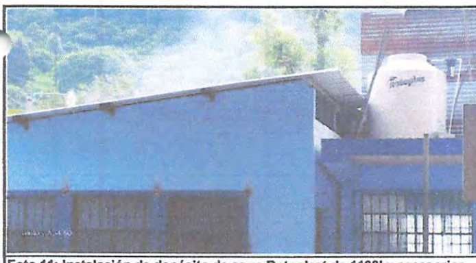
Foto 11: Instalación de depósito de agua Rotoplast de 1100l y accesorios.
