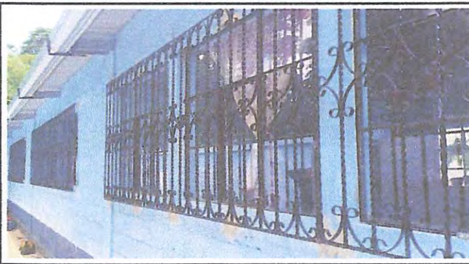
Foto 8: Suministro, fabricación e instalación de balcones de metal con medidas de 1.50m x 1.25m para seguridad en salones
