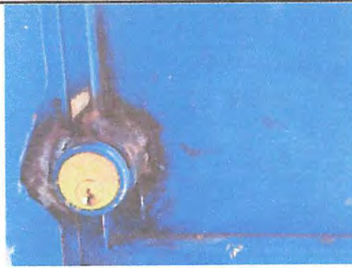
Foto 16: Suministro e instalación de chapa en puerta marca yale para salón
