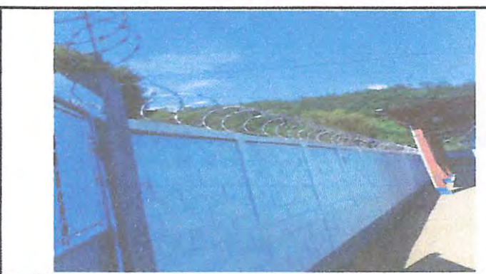
Foto 10: MUROS PERIMETRALES Instalación de razor(cerco de alambre de púa) de acero inoxidable rollo de 10 ML
