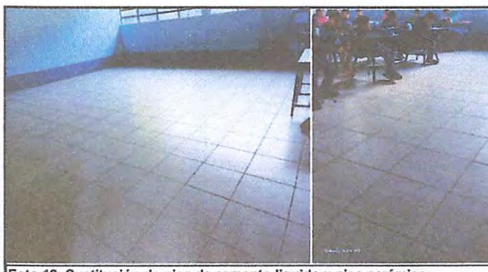
Foto 12: Sustitución de piso de cemento líquido x piso cerámico antideslizante
