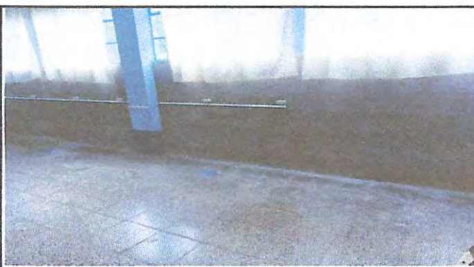
Foto 4: Cernido y ensabietado de pared.
