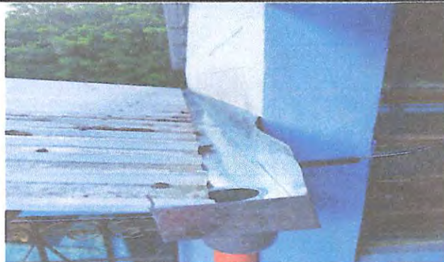
Foto 2: Suministro e instalación de 7 metros de canal de metal calibre 26'' con soporte y bajadas de agua
