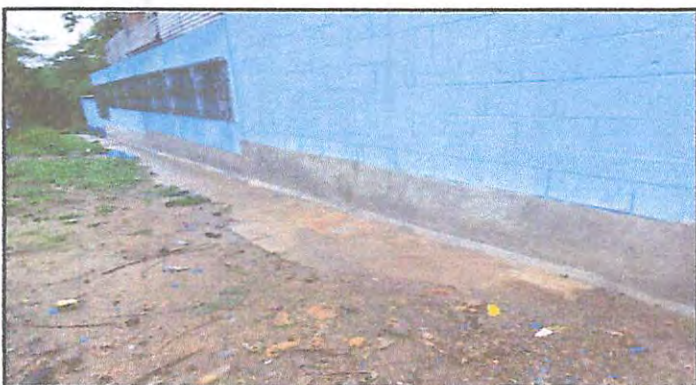
Foto3: Cernido y ensabietado de pared.
