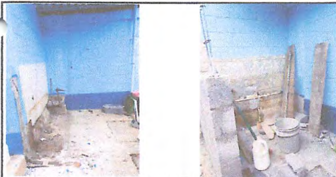
Foto 5: SERVICIOS SANITARIOS Y ACCESORIO (Remodelación de Mingitorios)
