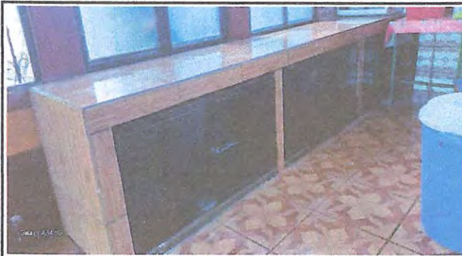
Foto 14: Suministro, fabricación e instalación de puertas de metal de dos bandas para gabinete de concreto en cocina (No se tomo foto en el momento de la instalación)
