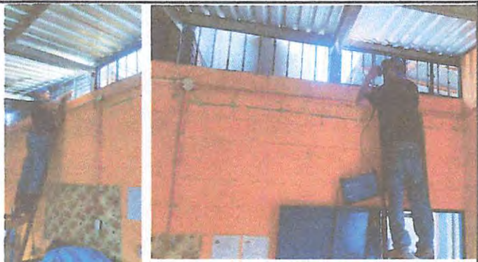
Foto 7: suministro, fabricación e instalación ventanas de metal más vidrio transparente de 3mm con medida de 1.46m x 40m para área de cocina
