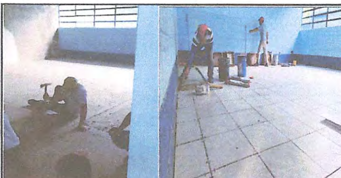
Foto 12: Sustitución de piso de cemento líquido x piso cerámico antideslizante
