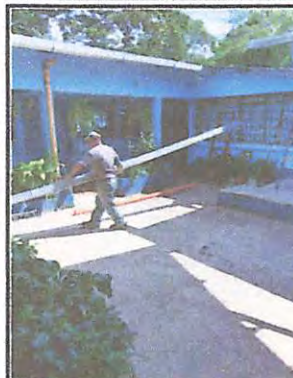
Foto 2: Suministro e instalación de 7 metros de canal de metal calibre 26" con soporte y bajadas de agua
