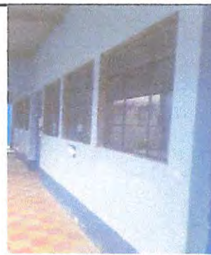
Foto 6: suministro, fabricación e instalación de ventanas de metal con vidrio transparente de 5mm con medidas de 1.35m x 1.13m para sustitución de ventanas de madera en salones
