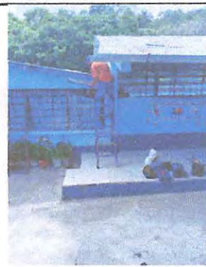
Foto 2: Suministro e instalación de 7 metros de canal de metal calibre 26" con soporte y bajadas de agua
