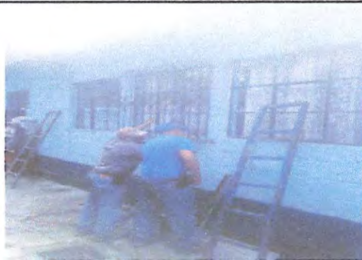
Foto 8: Suministro, fabricación e instalación de balcones de metal con medidas de 1.50m x 1.25m para seguridad en salones
