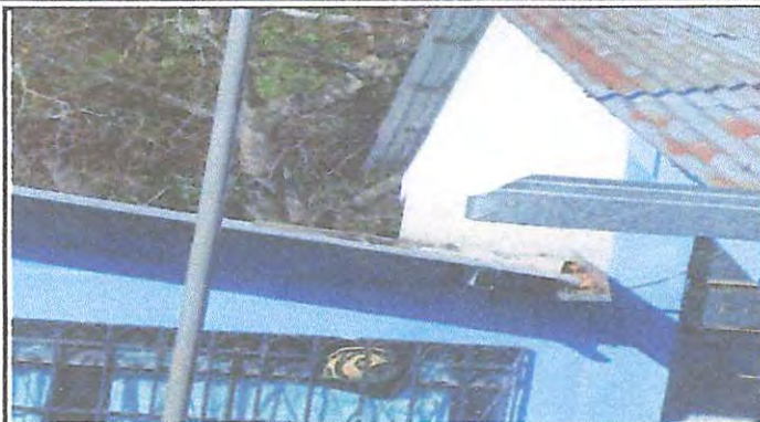
Foto 2: Suministro e instalación de 7 metros de canal de metal calibre 26'' con soporte y bajadas de agua
