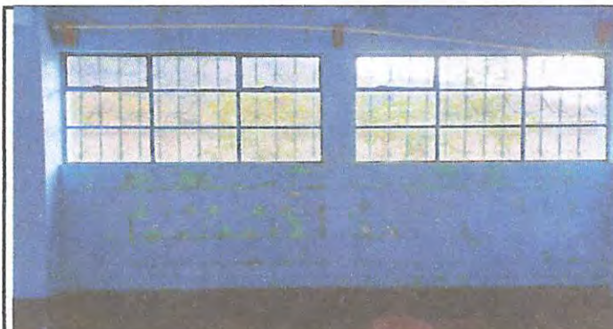
Foto 4: Cernido y ensabietado de pared.
