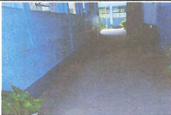
Foto 13: Sustrucción de piso de torta de concreto x piso cerámico antideslizante
