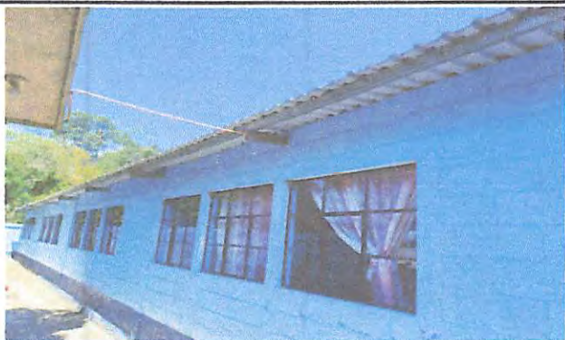
Foto1: Suministro e instalación de 27 metros de canal de metal calibre 26'' con soporte y bajadas de agua
