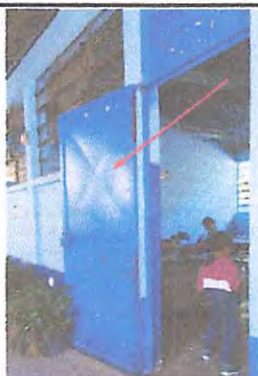
Foto 15: Quitar, cortar de largo e instalar 3 puertas de metal en salones.
