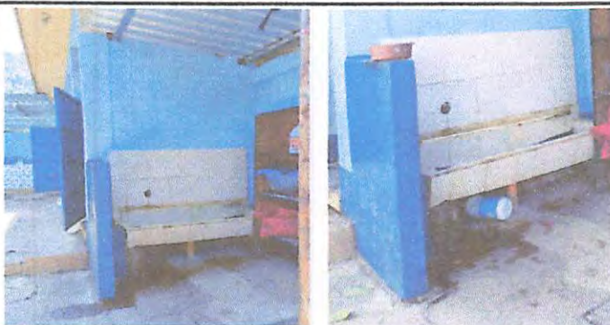
Foto 5: SERVICIOS SANITARIOS Y ACCESORIO (Remodelación de Mingitorios)
