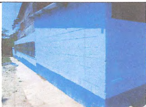
Foto3: Cernido y ensabietado de pared.
