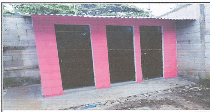
Foto 6: Finalización del servicio sanitario
