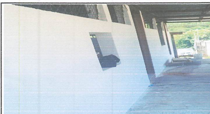
Foto 3: Finalización del cernido y repello en paredes de cocina y corredor
