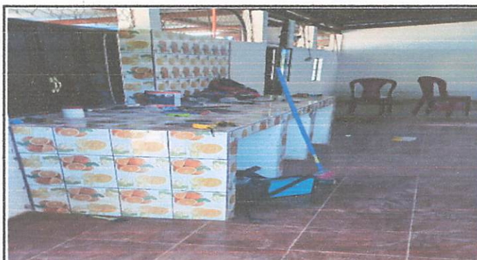
Foto 4: Finalización de la mesa de concreto
