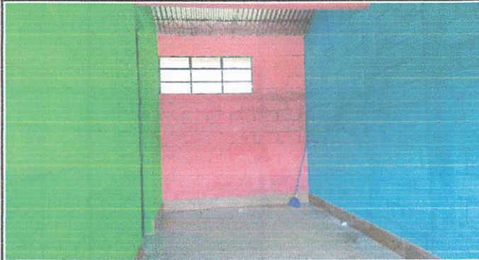
Foto 1: Finalización de la pintura en paredes de salones y corredores
