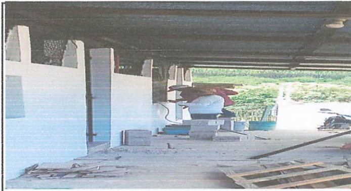
Foto 2: Instalación de puertas y ventanas de cocina
