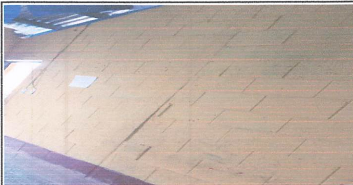
Foto 5: Inicio de colocación de duelas en paredes
