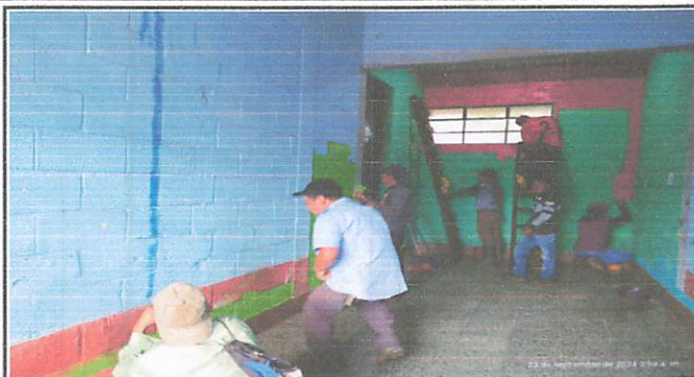
Foto 1: Inicio de pintura en paredes dentro y fuera de salones
