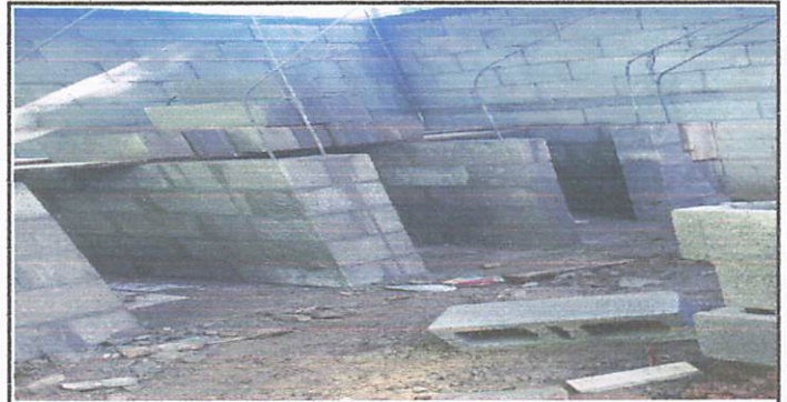
Foto 6: Inicio de mejoramiento de los servicios sanitarios
