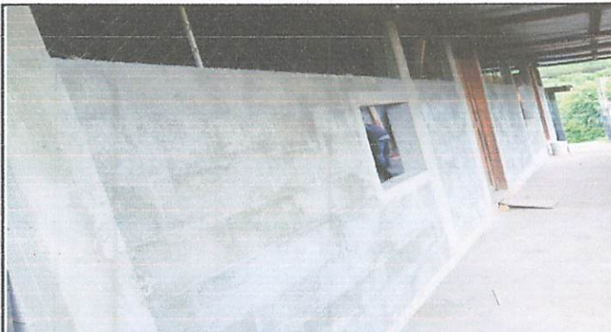
Foto 3: Inicio de cernido y repello en paredes dentro y fuera de la cocina
