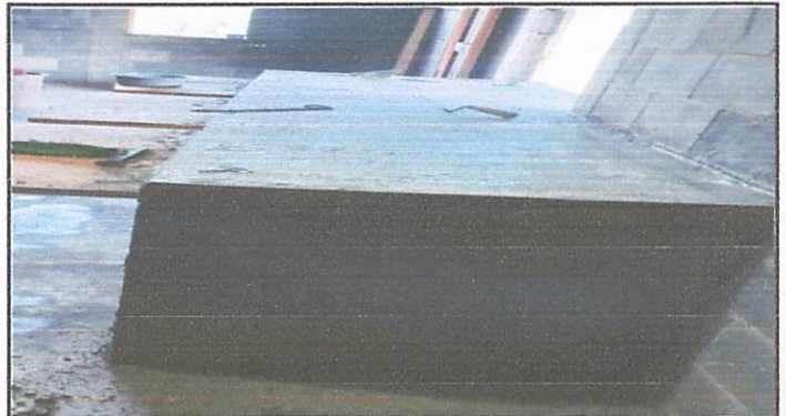
Foto 4: Inicio de mesa de concreto
