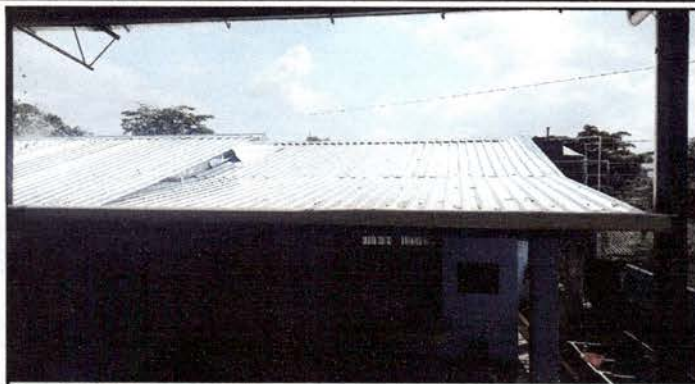
Foto1: Instalación de lámina finalizado.
