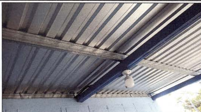
Foto 2: Instalación de portantes de metal finalizado.
