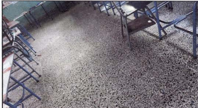
Foto 2: Piso de granito instalado en salón de párvulos. Finalizado.
