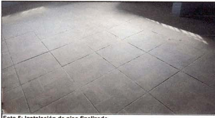
Foto 5: Instalación de piso finalizado.
