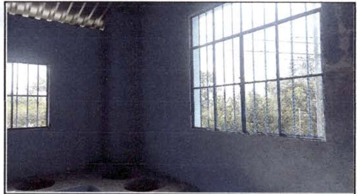
Foto 2: instalación de ventanas finalizado.
