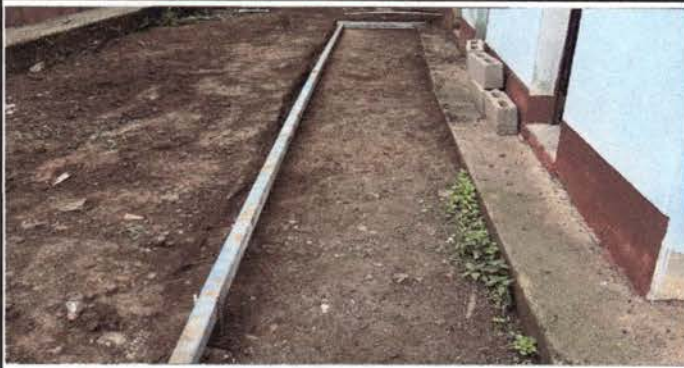
Foto 19: Cubrimiento con torta de cemento en patio de sanitarios.
