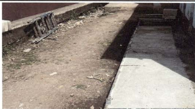
Foto 1: Torta de cemento en patio de sanitario finalizada.
