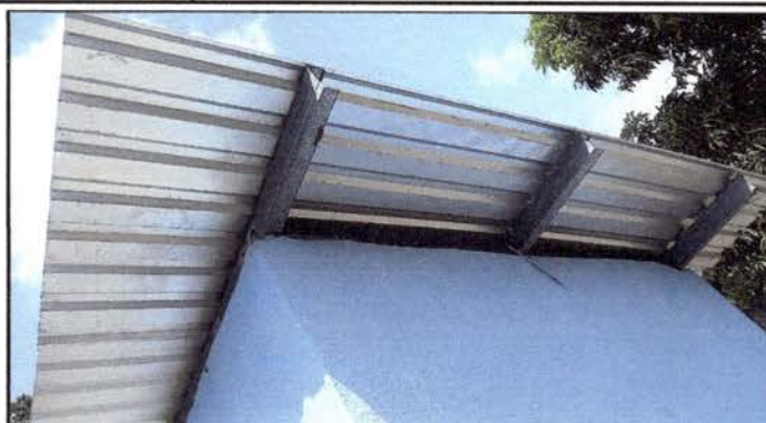
Foto 2: Instalación de portante de metal en sanitario finalizado.
