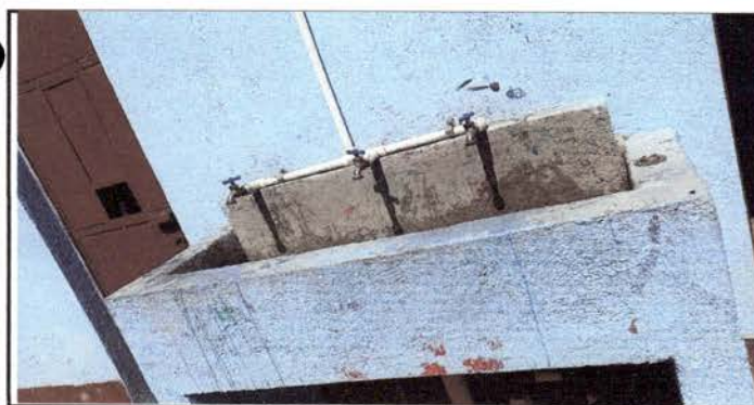
Foto 5: Módulo de lavamanos finalizado.
