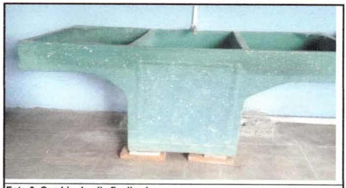
Foto 6: Cambio de pila finalizado.
