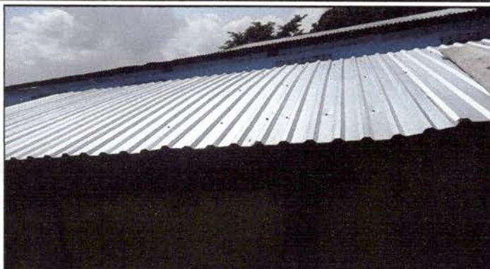
Foto1: Instalación de lámina troquelada en sanitario finalizado
