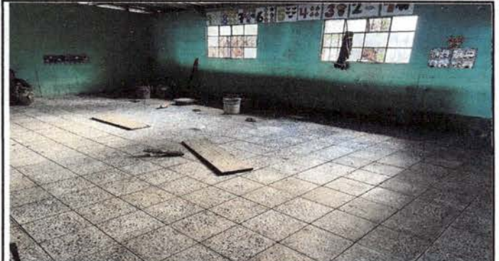
Foto 20: Instalación de piso de granito en salón de Párvulos.
