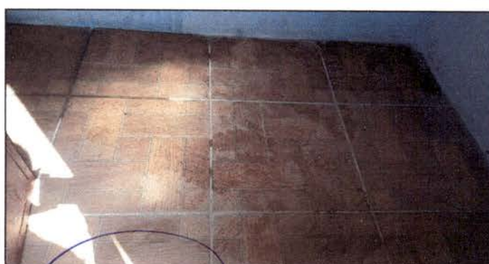
Foto 6: Piso instalado en sanitario finalizado.
