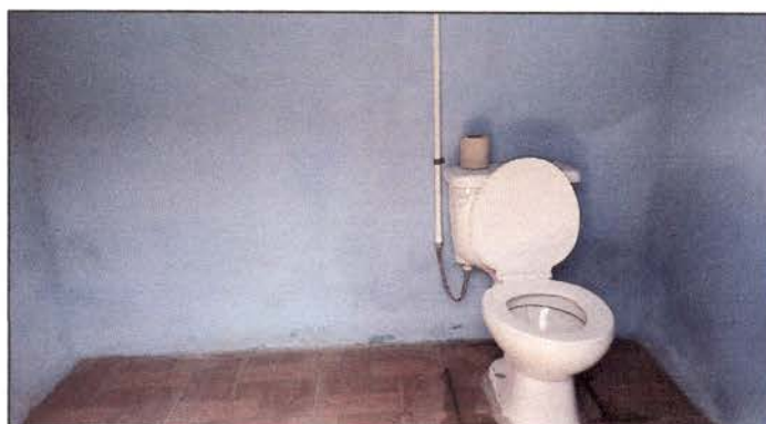
Foto 4: Cambio de tazas finalizado.
