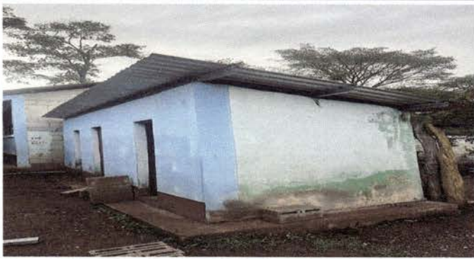
Foto 13. Cambio de lámina troquelada en sanitario.
