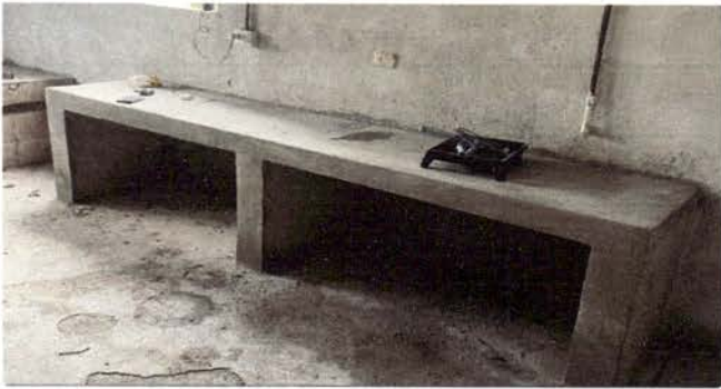
Foto 1: Mantenimiento de mueble de cocina por deterioro.
