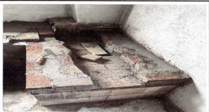
Foto 4: Mantenimiento y reparación de estufa rural.
