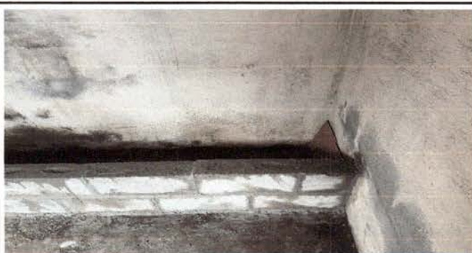
Foto 9: Fundición de mingitorio tipo pileta.
