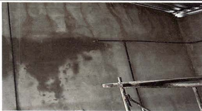
Foto 3: Colocación de repello, cernido y pintura en muros de cocina
