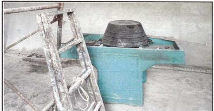
Foto 6: Cambio de pila.
