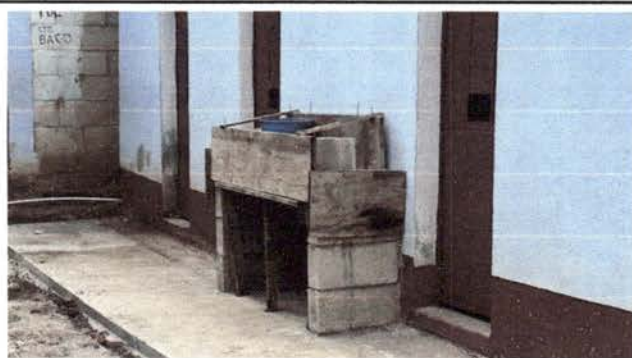
Foto 11: Instalación de lavamanos tipo pileta.
