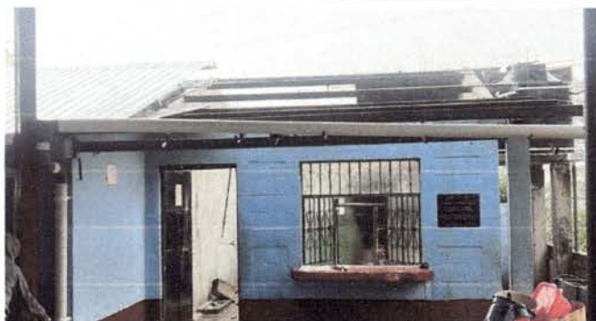
Foto 7: Desmontaje e instalación de lámina troquelada en cocina.
