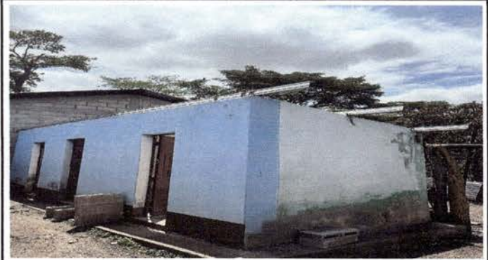
Foto 14. Ajuste e instalación de portante de metal.
