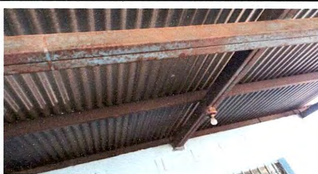
Foto 8: Mantenimiento e intalacion de estructura portante de metal.
