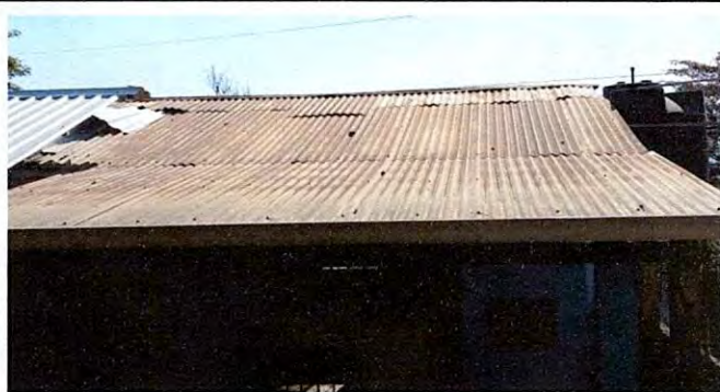
Foto 7: Desmontaje e instalacion de lámina troquelada en cocina.
