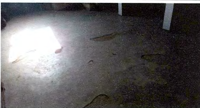
Foto 5: Instalación de piso antideslizante en cocina.
