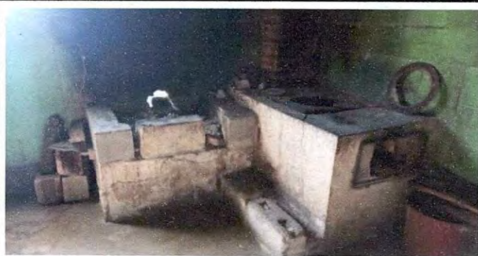
Foto 4: Mantenimiento y reparación de estufa rural.
