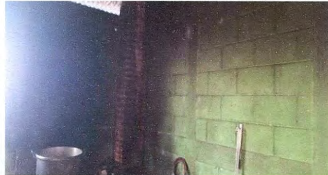
Foto 2: Instalación de ventanas por falta de iluminación y ventilación de cocina.
