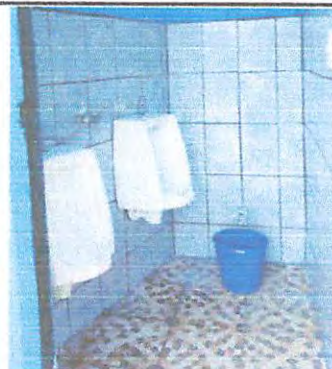
Foto 2: Modificación e instalación de 2 mingitorios de porcelana
