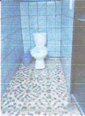
Foto1: Cambio de taza sanitaria en mal estado.
