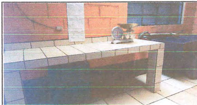
Foto 4: Construcción de Top de concreto
