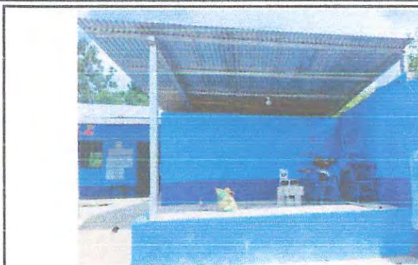
Foto2: construcción muro escenario.
