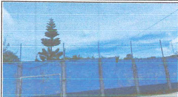
Foto1: Reparación de pared y pintura enfrente de cancha
