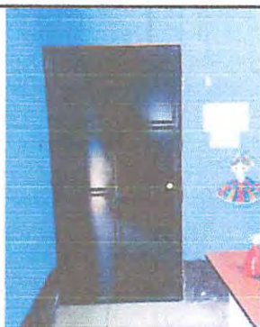
Foto 5: Cambio de puerta de playwood por puerta de metal de cuarto grado
