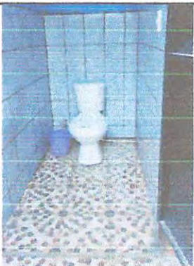
Foto 3: Cambio de azulejo en sanitarios.
