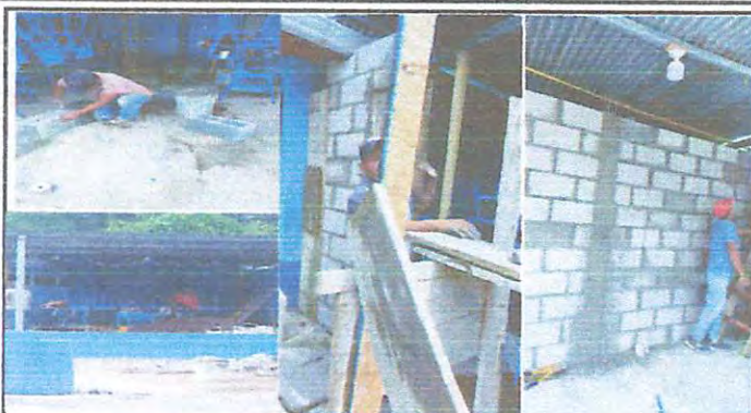
Foto2: construcción muro escenario.
