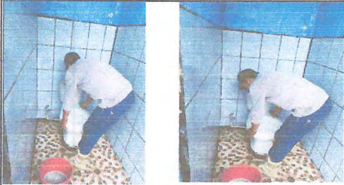
Foto1: Cambio de taza sanitaria en mal estado.
