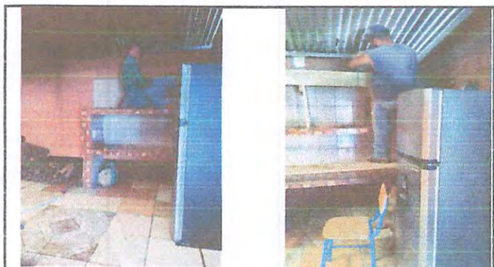
Foto 3: Ampliación de gabinetes y colocación de sus respectivas puertas en los gabinetes
