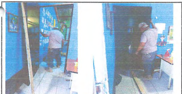
Foto 5: Cambio de puerta de plywood por puerta de metal de cuarto grado
