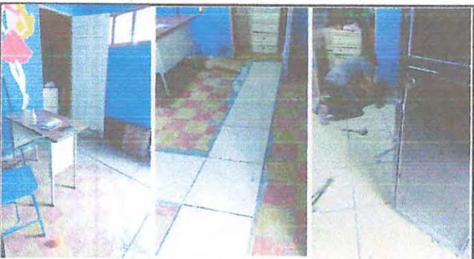
Foto 3: Cambio de piso por cerámica de la dirección
