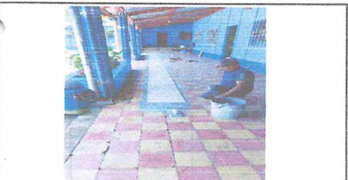
Foto 5: Colocación de piso ceramico en corredor de preprimaria, quinto y sexto
