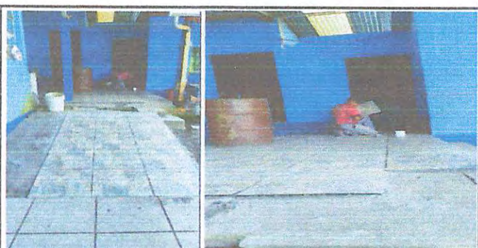
Foto 6: Colocación de piso cerámico enfrente de cocina
