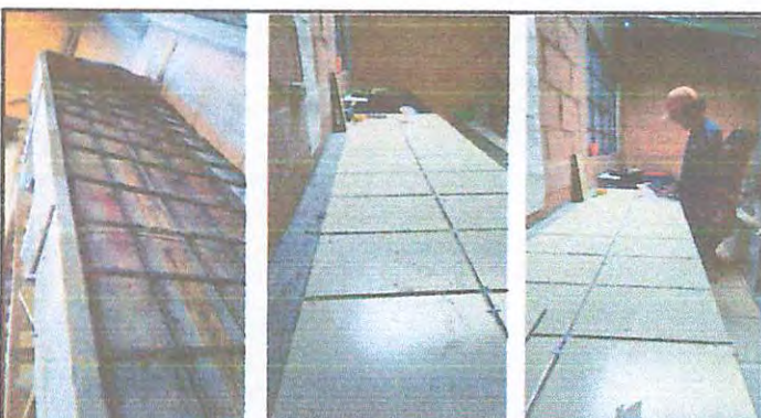
Foto 4: Construcción de Top de concreto
