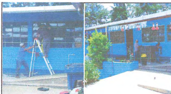
Foto 4: Fabricación e instalación de dos balcones
