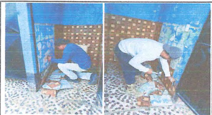
Foto 3: Cambio de azulejo en sanitarios.
