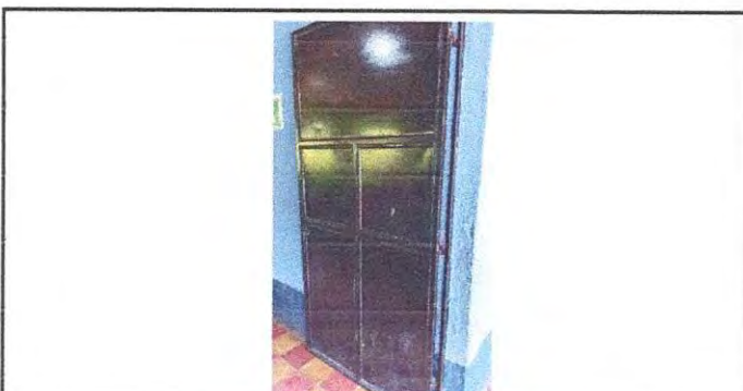
Foto 6: Reparación y cambio de chapas
