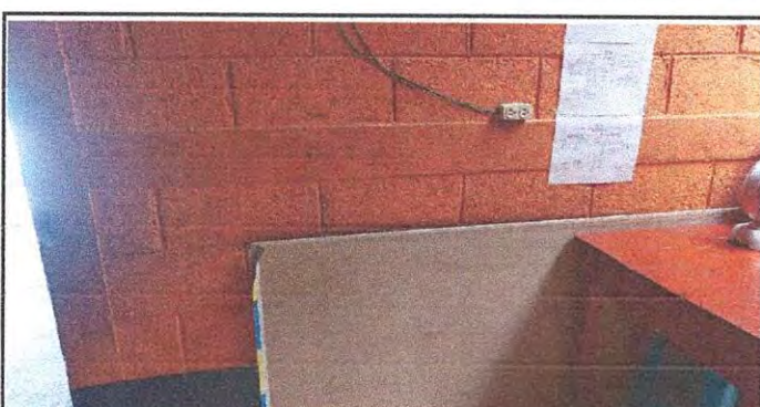
Foto 4: Construcción de Top de concreto
