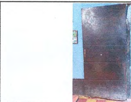
Foto 5: Cambio de puerta de playwood por puerta de metal de cuarto grado
