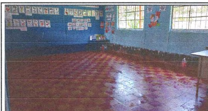
Foto 4: Sustitución de piso ladrillo de color por cerámica del aula de primer grado
