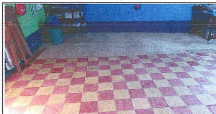
Foto 3: Sustitución de piso ladrillo de color por cerámica en aula de cuarto
