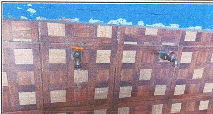
Foto 2: Cambio de los 4 chorros en mal estado
