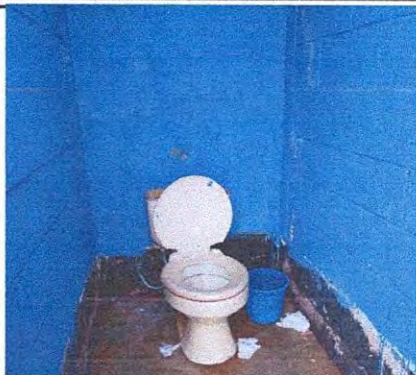
Foto1: Cambio de taza sanitaria en mal estado.
