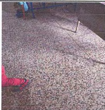
Foto 1: Cambio de piso de granito por cerámico en el nivel Preprimario
