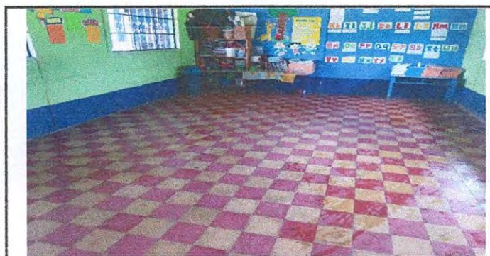
Foto 5: Sustitución de piso ladrillo de color por cerámica en la aula de segundo y tercero
