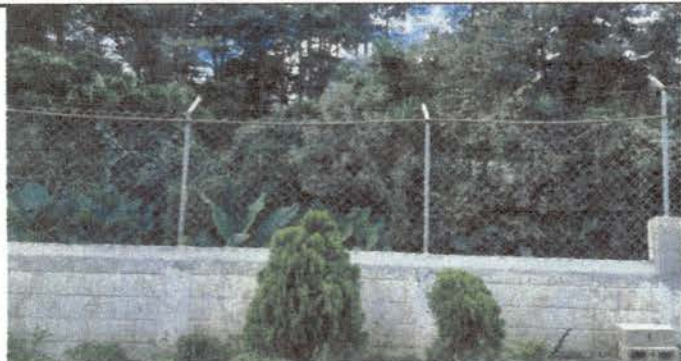
Foto 1: Instalación completa del cambio de malla
