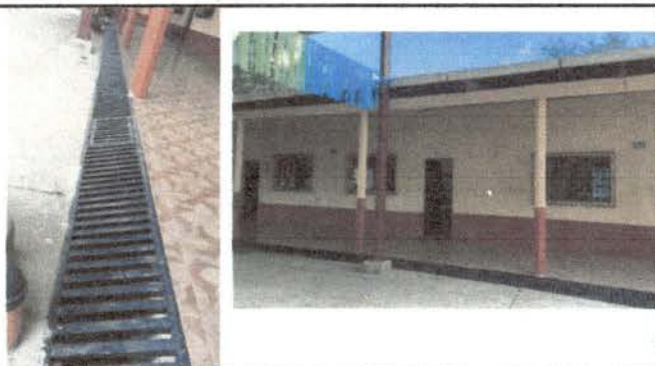
Foto 5: fabricacion e instalacion de parrilla en sanja de bajadas de agua
