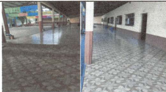
Foto 3: Instalación completa de piso en corredor
