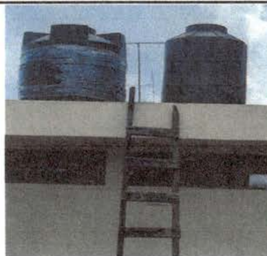
Foto 2: instalación completa de tinaco
