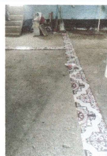
Trazado de guías para la colocación de piso y que quede a escuadra.
