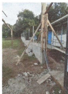
Levantado de columnas donde se colocará el portón.
