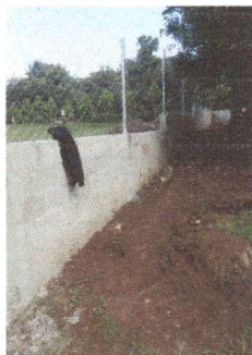
Proceso de levantado de pared del muro perimetral,
