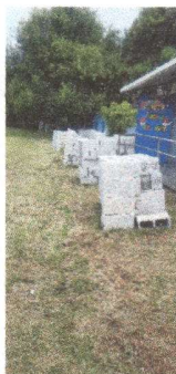
Preparación de area de contrucción de muro perimetral parte frontal.
