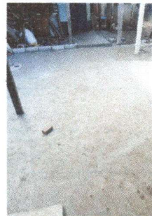
Fundición de la sosa de cemento.
