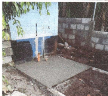
Preparación del área donde se contruirá la pila
