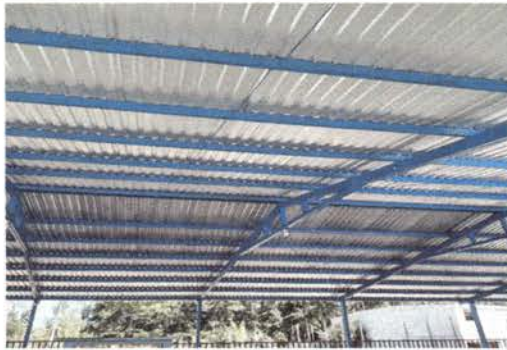
Foto 3: Costaneras, vigas y estructura completamente pintados
