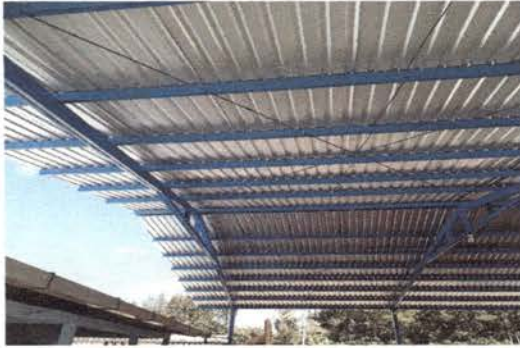
Foto1: Montaje de láminas completado
