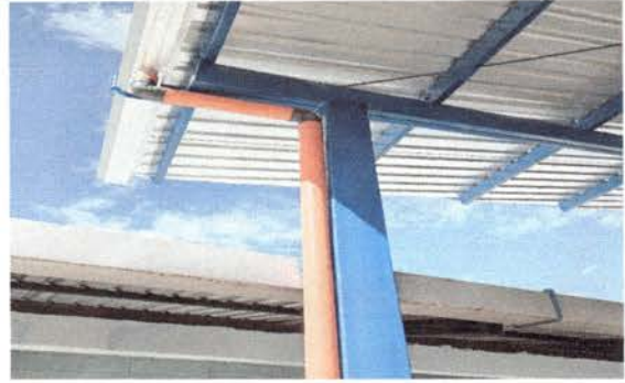
Foto 2: Instalación de canaletas u tubos de de bajada completado
