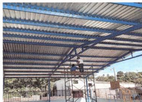
Foto 4: Afinando ultimos detalles para entrega de los trabajos terminados
