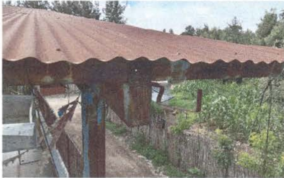
Foto1: Se desinstalará la lámina oxidada y se instalará lámina troquelada, también se limiará y se pintará la estructura
