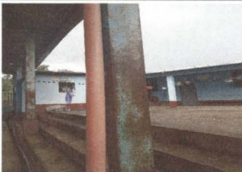
Foto 5: Se lijarán y se pintarán con material anticorrosivo toda la estructura metálica del techo de la cancha. Porque tiene mas de 20 años sin intervención
