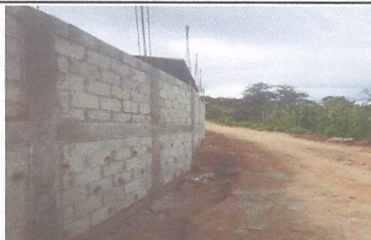
Foto 6: Nuestro muro terminado.
