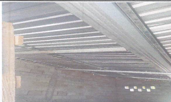
Foto 3: Colocacion de techo.
