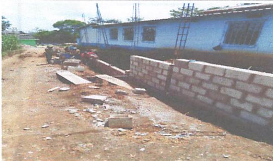
Foto 5: Trabajando en el muro
