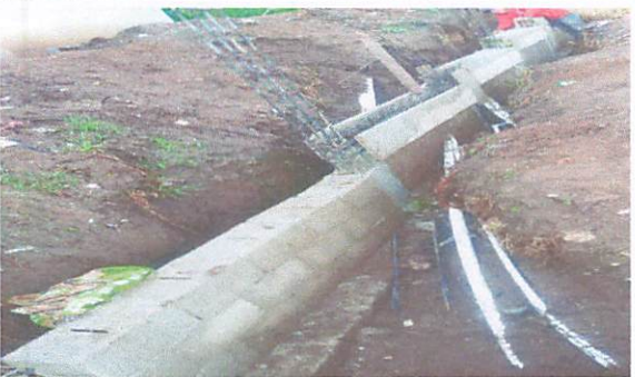
Foto 3: Muro saliendo de tierra.
