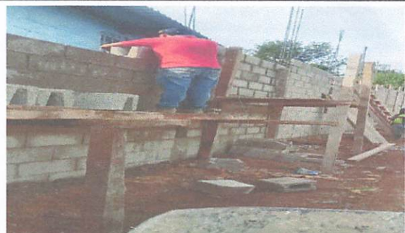
Foto 6: Nuestro muro ya casi por terminar.
