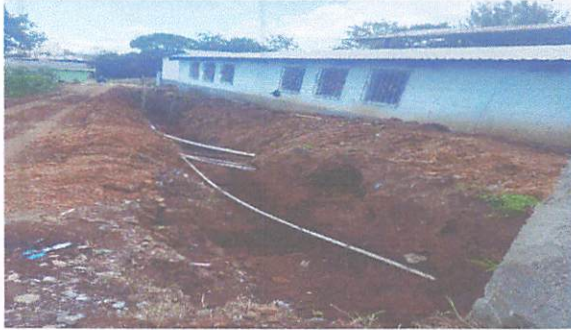
Foto: Comienso del trabajo en el muro
