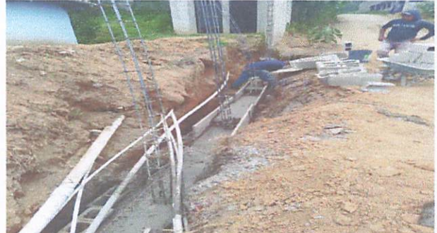
Foto 2: terminando la fundicion de solera de nuestro muro.
