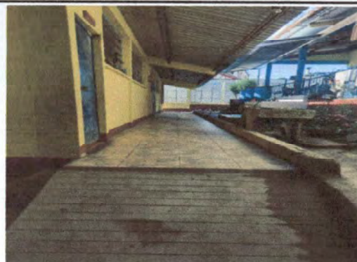
Foto 8: Piso pasillo 1 planta alta
