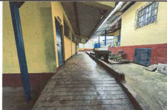
Foto 8: Piso pasillo 1 planta alta
