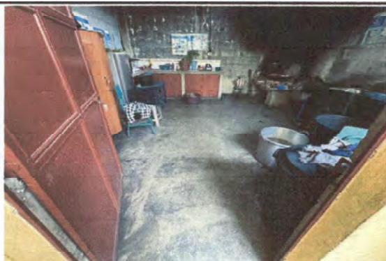
Foto 3: Piso en cocina
