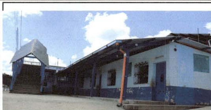
Foto1: Modulo 2 Cambio de techado completo de 2 salones que se encuentra en la entrada del lado izquierdo de la escuela, cambio de parales y colocación de lineales de canales enfrente y atrás de los salones.
