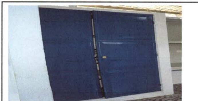
Foto 6: Remodelación de trinchante de alimentos se fundirá tres espacios de concreto y se cambiara la puerta por una de metal de dos bandas con chapa yale.
