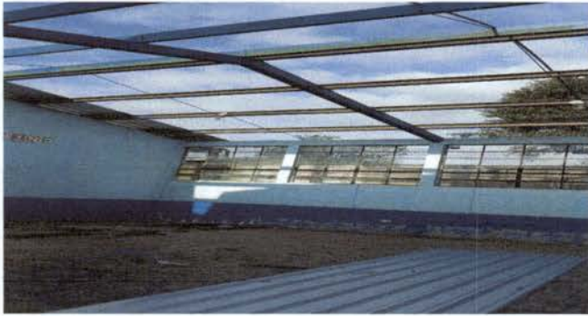
Foto 1: Modulo 2 Cambio de techado completo de 2 salones que se encuentra en la entrada del lado izquierdo de la escuela, cambio de parales y colocación de lineales de canales enfrente y atrás de los salones.
