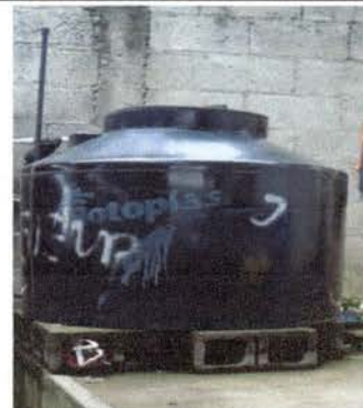
Foto 4: Cambio de tinaco pequeño por otro mas grande ya que no se da abasto para la distribución de agua.
