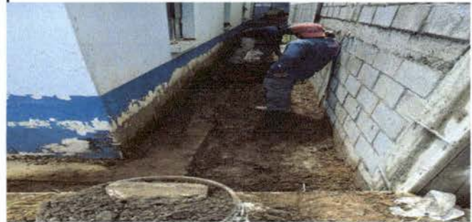
Foto 2: Mejoramiento de cuneta de Cuneta exterior y muro de block
