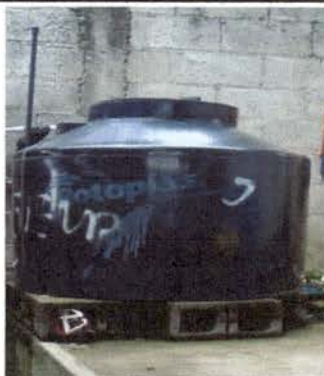
Foto 4: Cambio de tinaco pequeño por otro mas grande ya que no se da abasto para la distribución de agua.
