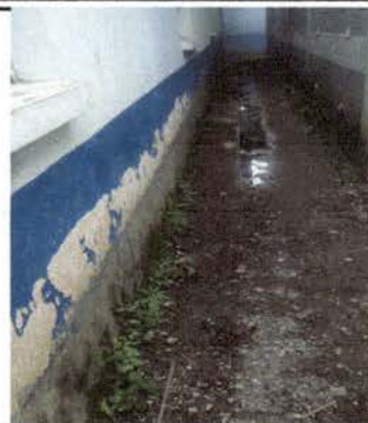
Foto 2: Mejoramiento de cuneta de Cuneta exterior
