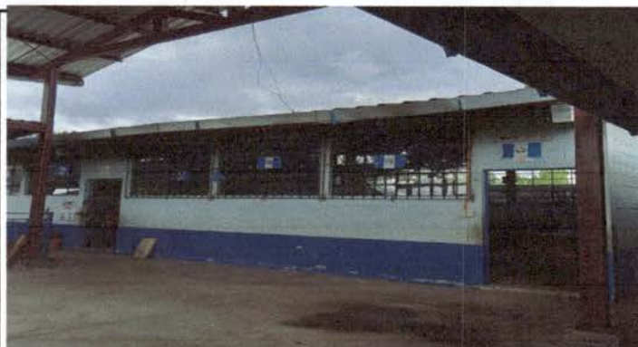
Foto 3: Modulo 1 Cambio de techado de dos salones area de referencia dirección, y mantenimiento delas costaneras con pintura
