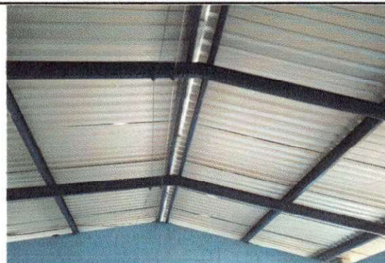
Foto 2: Cambio de techo de aulas, vista desde el interior.
