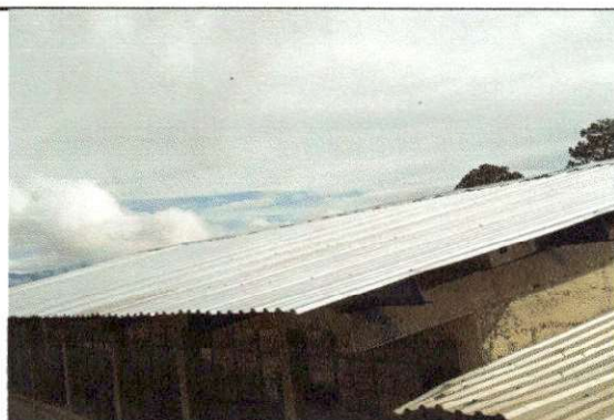
Foto 3: Aulas con nuevo techo, vista desde el exterior.
