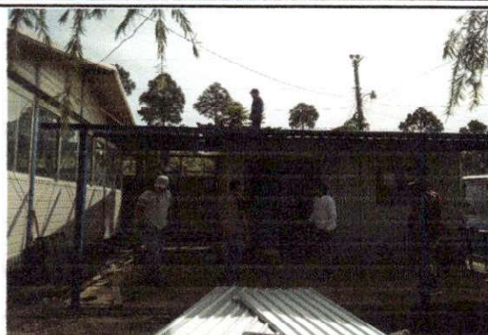
Foto 2: Agrandando cocina, a la vez colocando techo y corredor.
