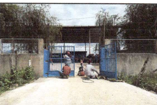
Foto 6: Levantamiento y pintura del portón.
