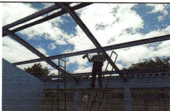
Foto 5: Pintando costaneras para colocar nuevo techo.
