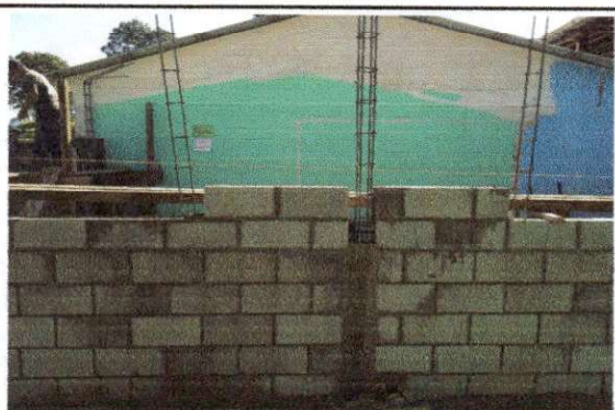
Foto 3: Levantando pared para el aula que necesita remozamiento.
