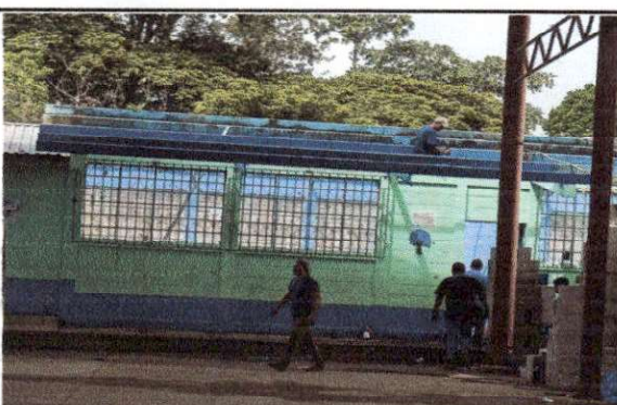
Foto 4: Limpiando costaneras para pintarlos y colocarles nuevo techo.
