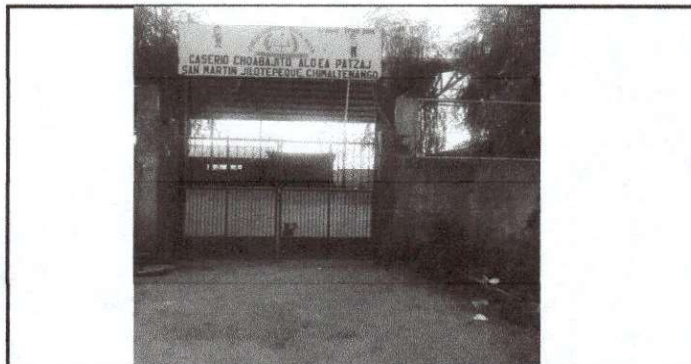
Foto 6: Levantado de portón del establecimiento, el cual ayudará el ingreso de furgones para el ingreso de los diferentes programas.
