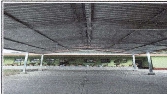
Foto 4: ESTRUCTURA METALICA - TECHADO - CAIDAS DE AGUA - PAVIMENTACION DEL PATIO PRINCIPAL
