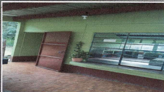
Foto 3: PISO - PINTURA - TECHO - ELECTRICIDAD
