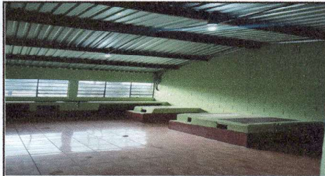
Foto 2: PISO - PLANCHAS - ELECTRICIDAD - LAMINA DE LA COCINA
