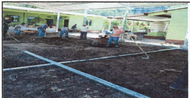
Foto 6: PAVIMENTACION DE PATIO PRINCIPAL
