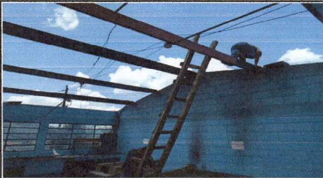
Foto 3: DESMONTAJE DE LAMINA DE LA COCINA
