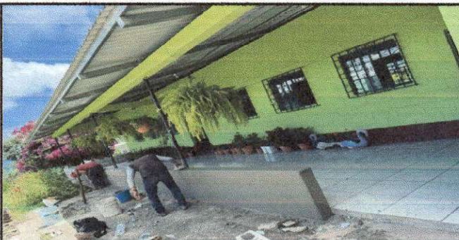
Foto 5: LEVANTADO DE 3 HILADAS DE BLOCK
