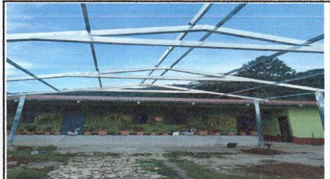
Foto 4: LEVANTADO DE ESTRUCTURA METALICA
