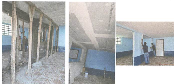
Construcción de pared dentro de Dirección para soporte de terraza y colocación de cielo falso tablayeso.
