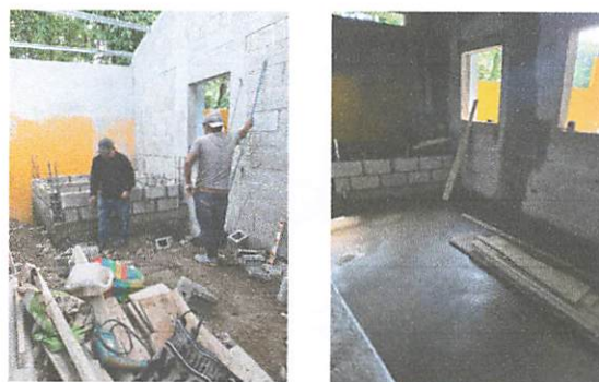
Construcción de pila grande con 2 lavaderos.
