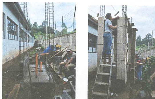
Avance de los trabajos de mejoramiento de pila.
