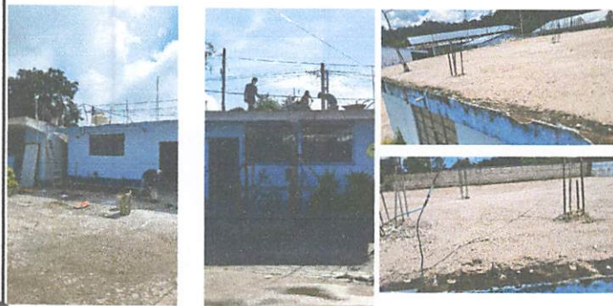
Trabajos para impermeabilizar las terrazas de dirección y dos salones más.
