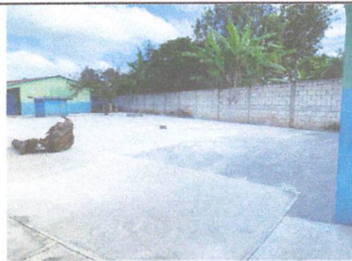
Foto 4: Colocación de torta de cemento
