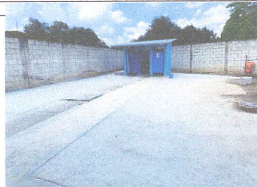
Foto 2: Colocación de torta de cemento.
