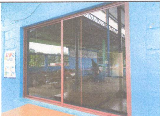
Foto 1: Mejoramiento de Ventanales
