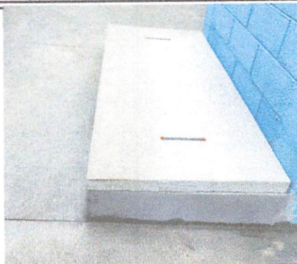
Foto 7: Colocacion de tapa de cemento de fosa séptica
