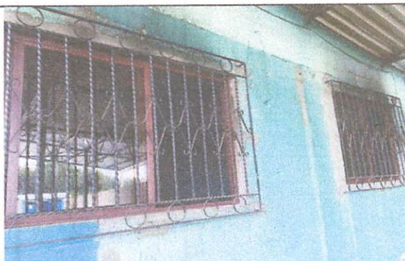
Foto 3: Mejoramiento de ambas ventanas.
