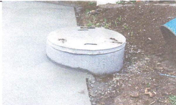
Foto 6: Colocación de tapa de cemento de drenaje.
