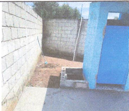
Foto 7 : Colocación de tapa de cemento de fosa séptica.
