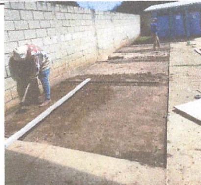
Foto 2: Colocacion de torta de cemento.
