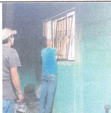
Foto 3: Mejoramiento de ventana.
